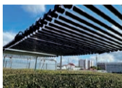
発電しながら光、風、雨を通す構造で、茶の生育にも配慮されています。
