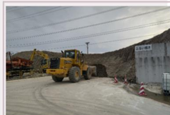
① 建設発生土(原料土)受入・搬入
