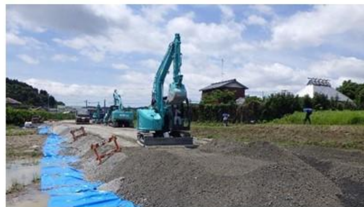
搬入された土砂を利用した工事用道路の整備状況
