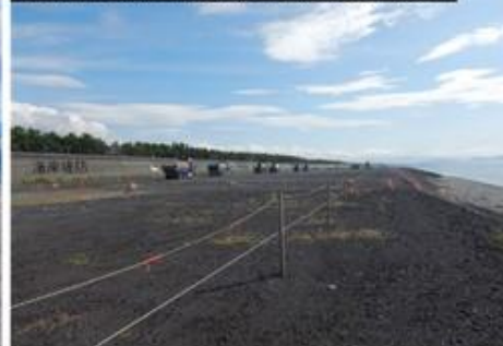
写真② 西側から東方向を望む(養浜盛土天端)
