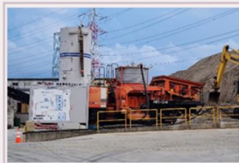
② 土質改良機によるセメント混合
