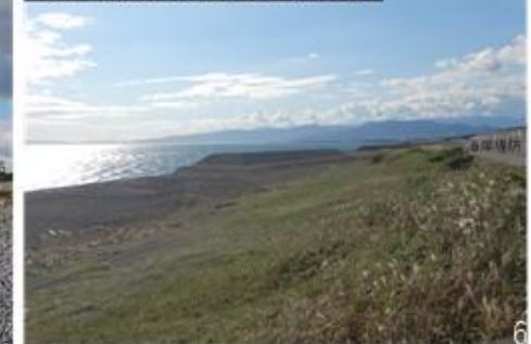
写真④ 東側から西方向を望む(陸側)
