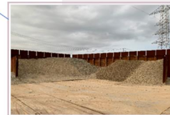
③ 養生後、切り崩し
