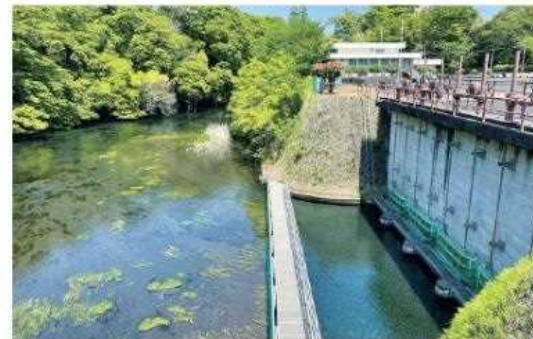
柿田川工業用水道 堂庭取水場（清水町）
