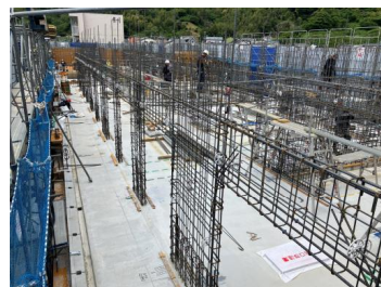
A棟3階壁・梁配筋
