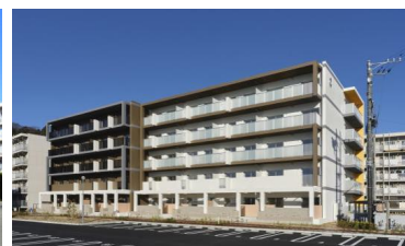
第1工区完成後
