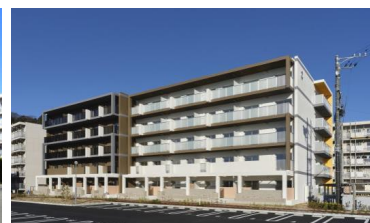
第1工区完成後
