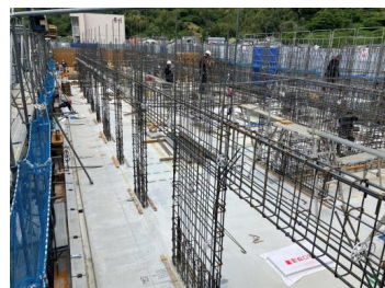
A棟3階壁・梁配筋
