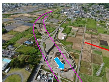
築堤盛土(県施工)
