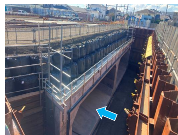
JR交差部 函体工 (JR委託工事)
