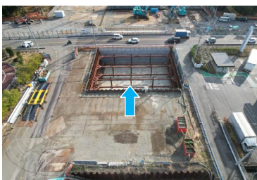
函体工(県施工)
