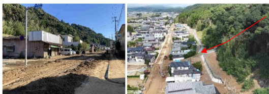
令和4年台風第15号時の状況（磐田市平松地区）
