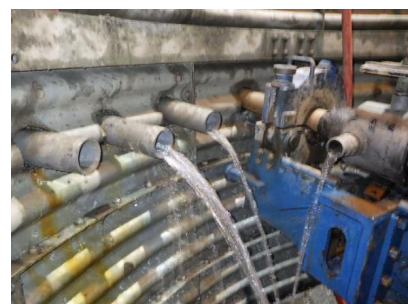
集水井工の効果(地下水排除の状況)
