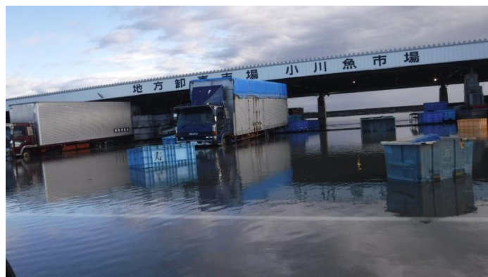
令和元年10月12日港内越波状況
