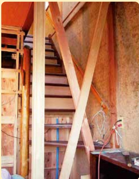
1 階玄関ホールに新設した筋かい
