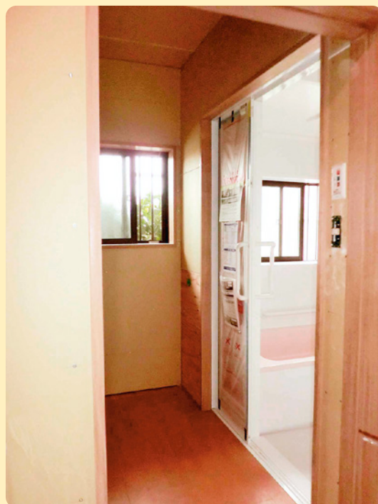
洗面と浴室の床段差解消
