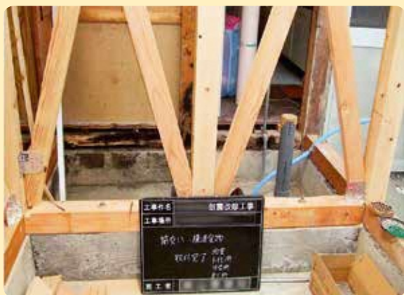
便所、浴室間に新設した筋かい
