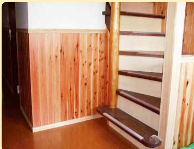
廊下、階段の腰壁に県産材を使用
