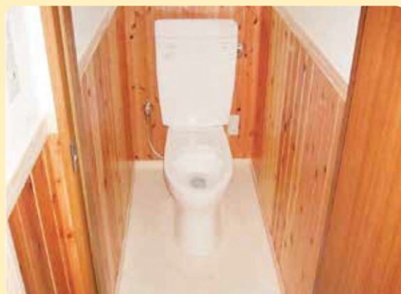
便所の腰壁に県産材を使用
