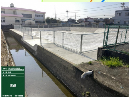
中郡町6号排水路工事 (中央土木整備事務所)
