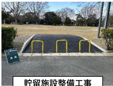
貯留施設整備工事 芳川公園 (公園管理事務所)
