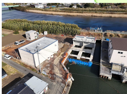
高塚ポンプ場状況 (中央土木整備事務所)
