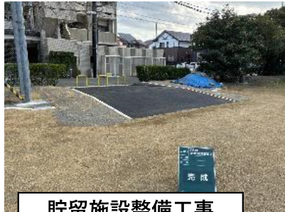
貯留施設整備工事 大蒲公園 (公園管理事務所)
