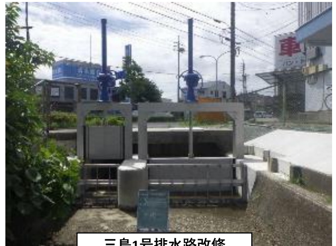
三島1号排水路改修 (中央土木整備事務所)
