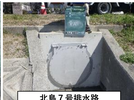
北島7号排水路 逆流防止施設整備 完成状況 (中央土木整備事務所)
