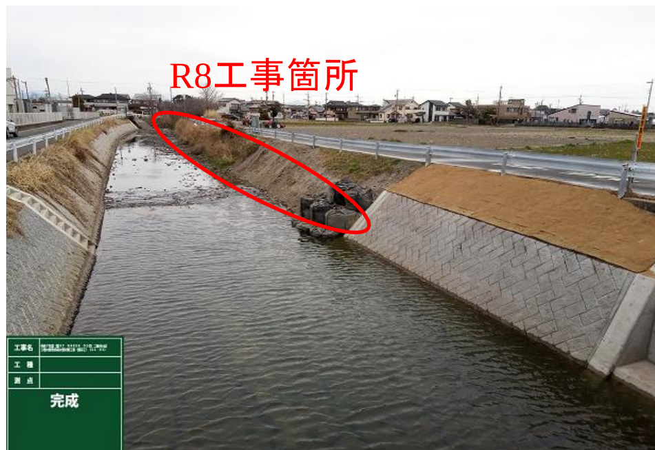
淵ノ上橋から上流から望む (R7工事完了)
