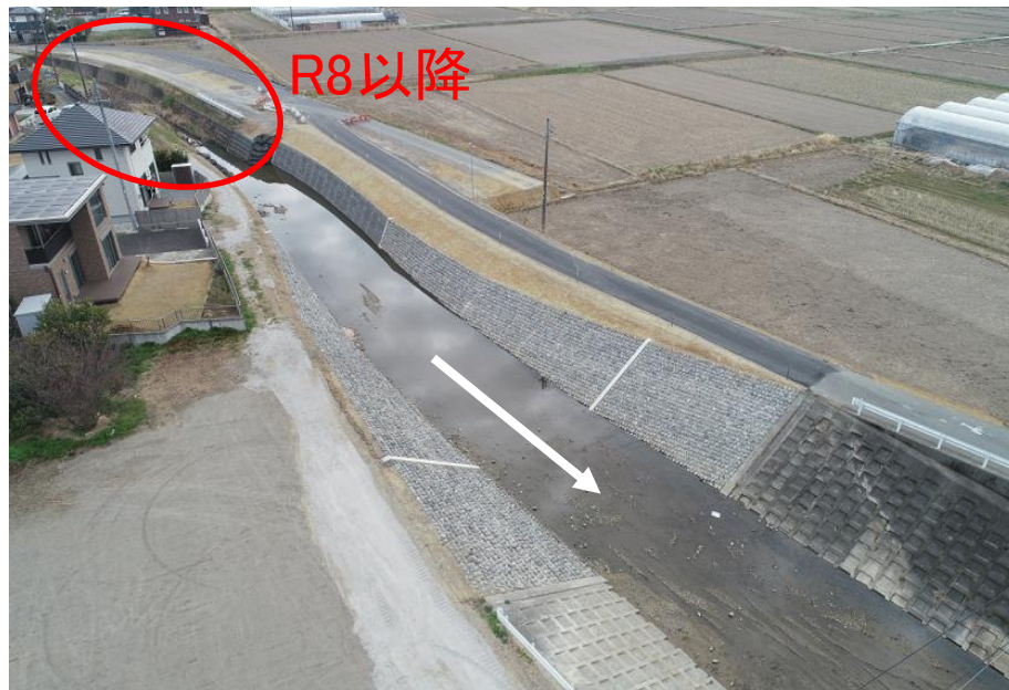
樋田橋から上流から望む (R7工事完了)
