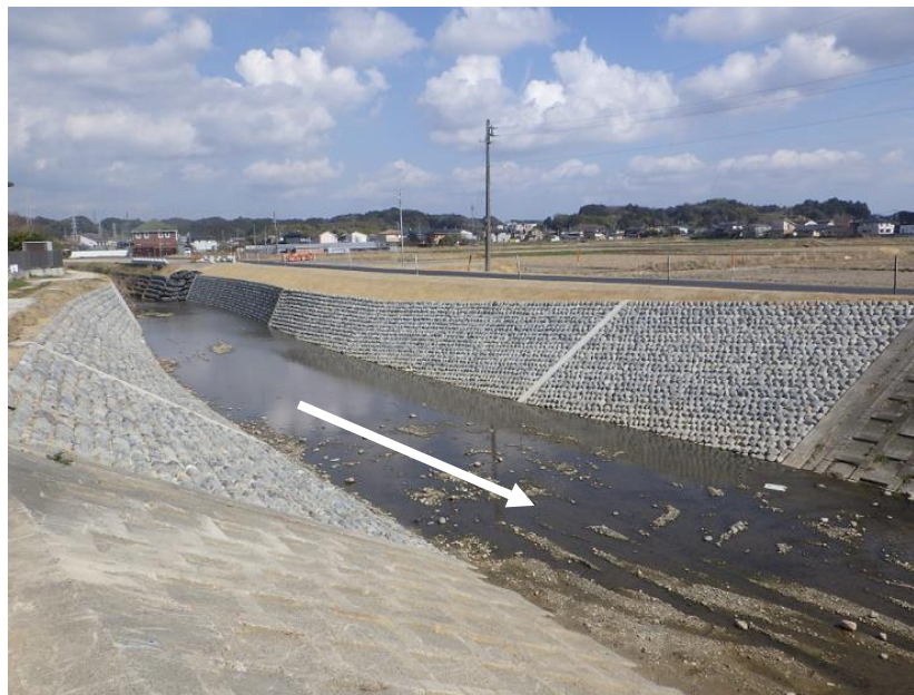
樋田橋から上流を望む (R7工事完了)
