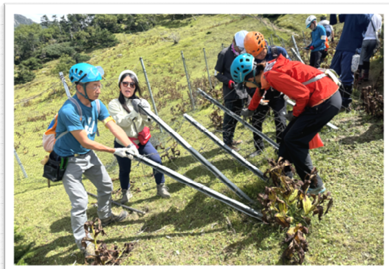
防鹿柵の補修作業
