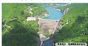
高知県 魚梁瀬ダム
