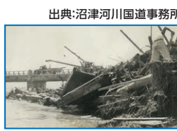
▲狩野川台風被害の様子
