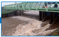
▲最大2,000m³/秒を放水する 狩野川放水路
