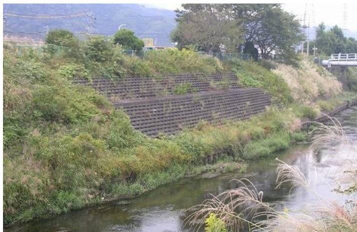
図 2-30 階段護岸の状況 -巴橋上流-
