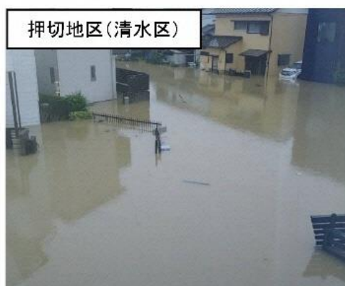
図 2-3 令和 4 年 9 月台風 15 号による浸水状況
