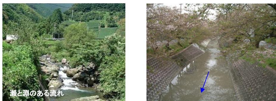
図 2-49 長尾川（左：葵区平山）、大沢川（右：清水区大坪）の河道の状況
