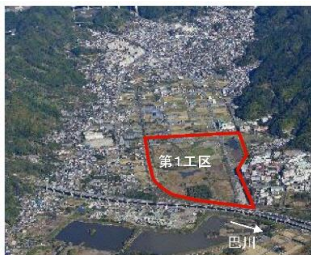
麻機遊水地第1工区
