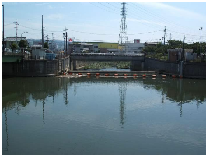
大谷川放水路分流工 -葵区古庄-
