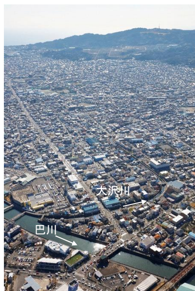
図 1-57 大沢川下流部 -清水区東大曲町付近-
