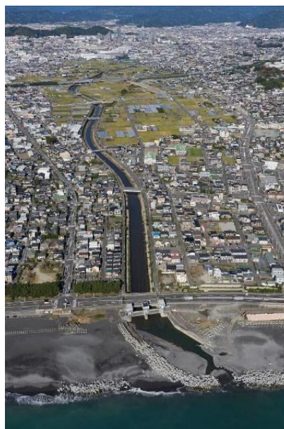
大谷川放水路河口部 -駿河区大谷-
