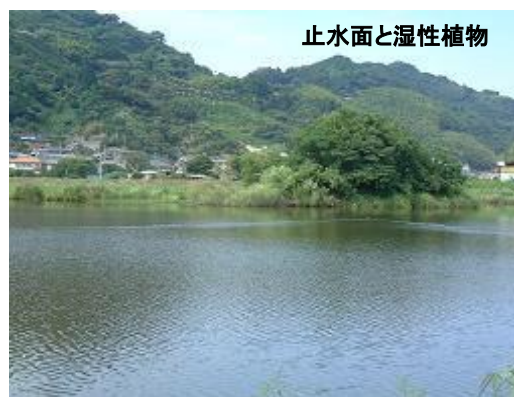
図 2-43 麻機遊水地第 4 工区の状況 - 葵区芝原 -
