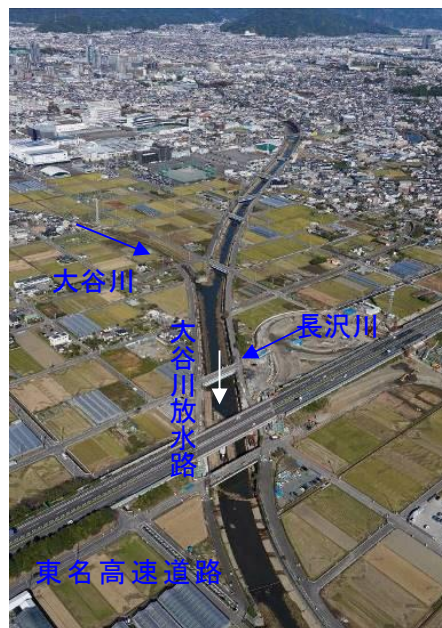
図 1-60 長沢川等の河道状況
