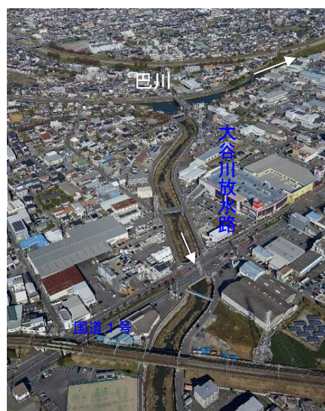
大谷川放水路分流堰 -葵区古庄-
