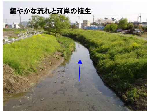
図 2-41 中流部の河道の状況 - 葵区漆山 -
