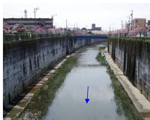
図 2-47 大谷川放水路の状況 - 駿河区小鹿 -
