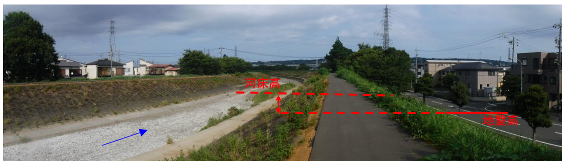
図 1-53 長尾川の天井川の状況 -葵区川合一丁目-
