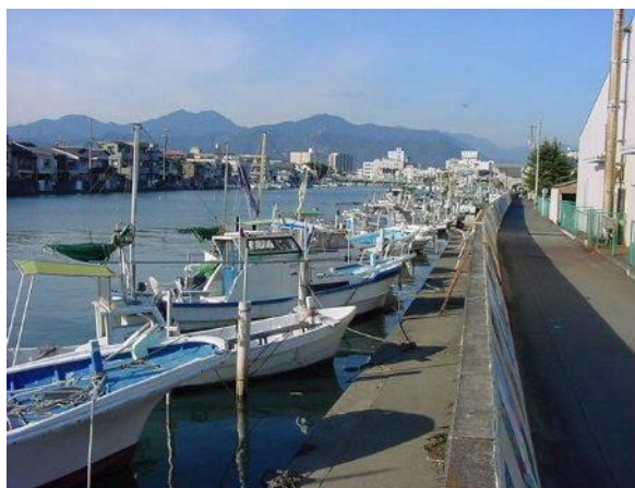
図 2-21 巴川暫定係留施設状況
