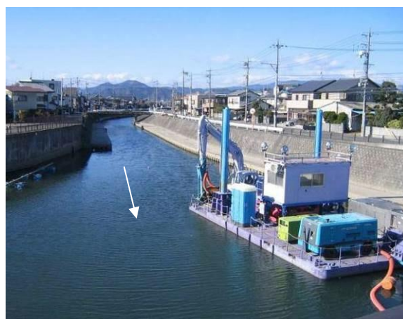
図 2-33 河川浄化の状況 (底泥の浚渫)
