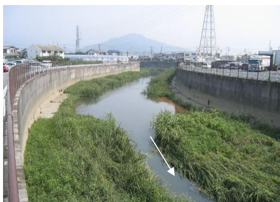
大谷川放水路 -葵区古庄 2 丁目
