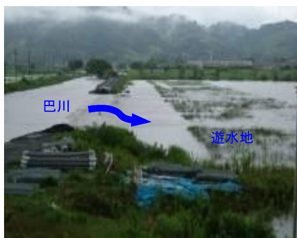
麻機遊水地第3工区 -葵区牛田-
