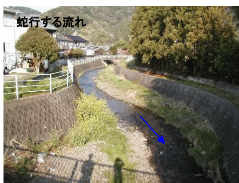
図 2-39 上流部の河道の状況 - 葵区北 -
