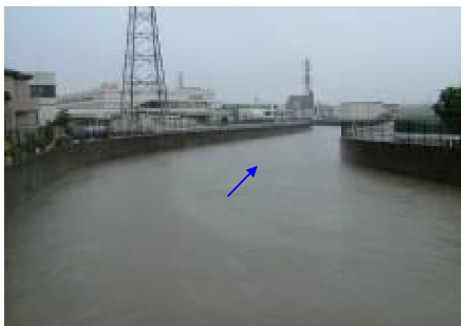
大谷川放水路 -葵区古庄-
