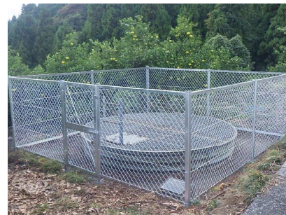
地すべり対策事業 白井沢西地区
