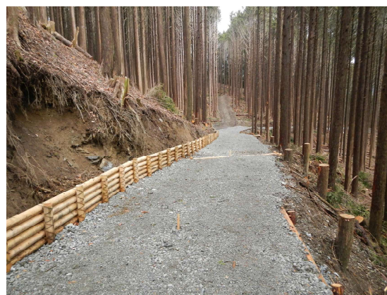
間伐・搬出に使用する森林作業道
