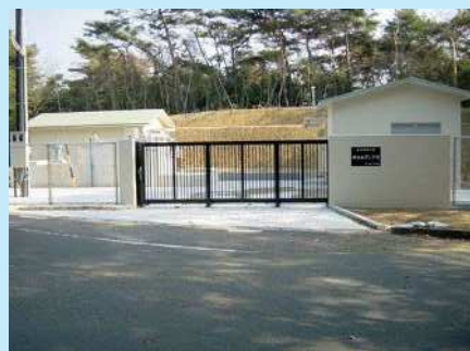
四大地ポンプ場
