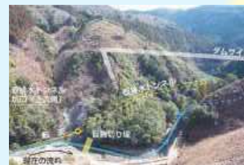
▲転流は上流側の坑口から川の流れを取り入れ、山の中を通して下流へ流します。
