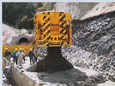
▲ コンクリート打設状況
