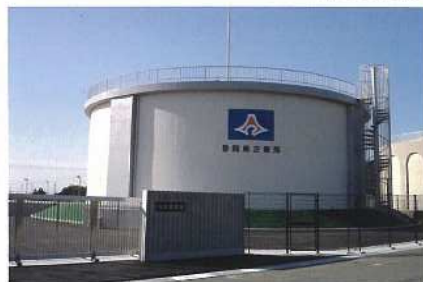
匂坂調整池 平成18年1月完成
