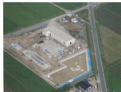
森取水ポンプ場 建設中
