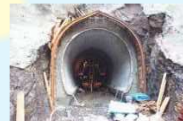
▲このトンネルは年1回程度の洪水を流すことの出来る大きさを確保しています。安全に洪水を流すためコンクリートで補強しています。
