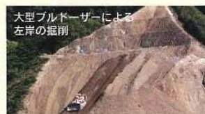
大型ブルドーザーによる左岸の掘削
