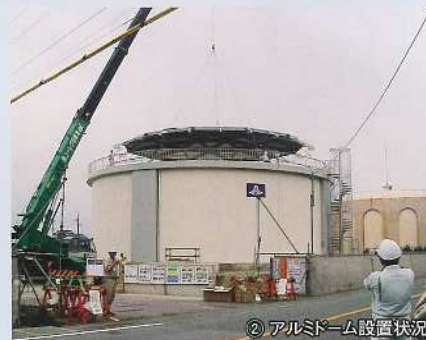
② アルミドーム設置状況
