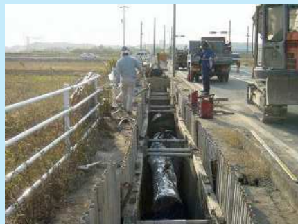
送水管の布設状況
