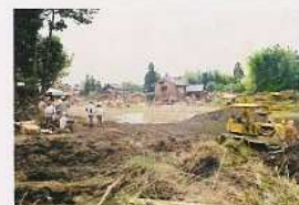
▲水が引いた後も復旧作業は続く… (袋井市横井地区)
