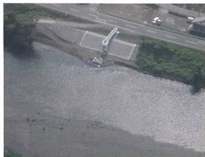
森取水場 建設中
