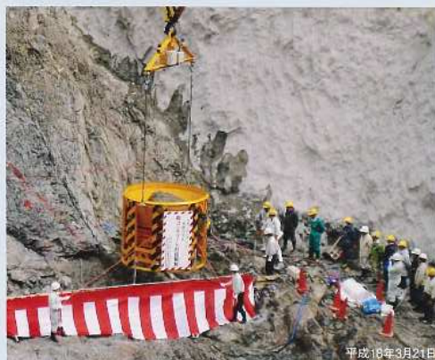
▲ コンクリート初打設式
