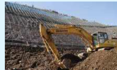
▲山を切り崩す作業で掘削機械が活躍しています。
