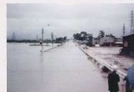
▲冠水した旧国道1号線 (磐田市三ヶ野地区)
