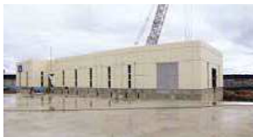
森ポン工場施工状況
