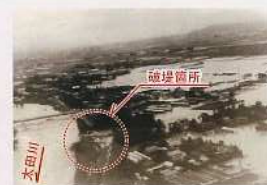
▲堤防が決壊し住宅地や農地が浸水している (袋井市延久地区)
