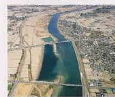
▲太田川河床掘削状況
