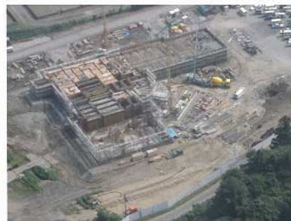
新寺谷浄水場管理本館 建設中
