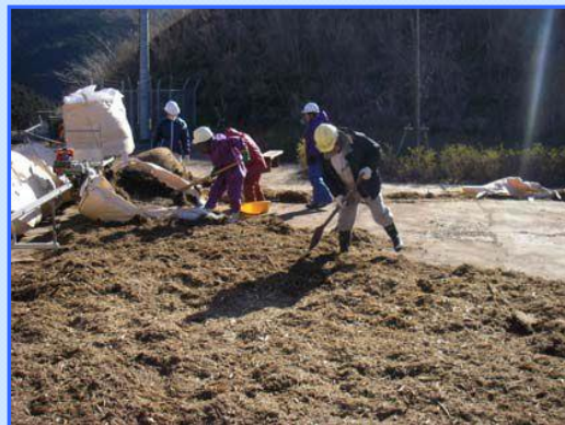
運搬して敷き均し
