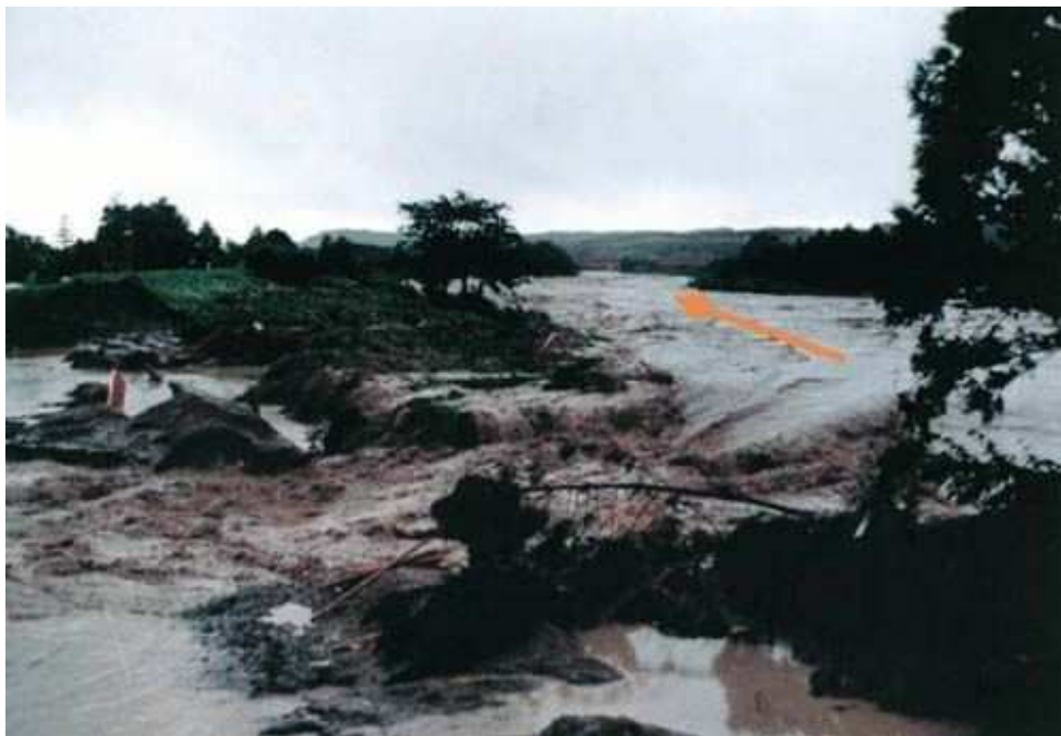
〔昭和 49 年 7 月 7 日洪水の被災状況〕
