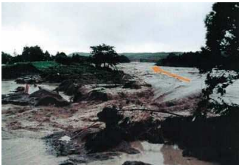
七夕豪雨による被災状況（袋井市延久付近）
