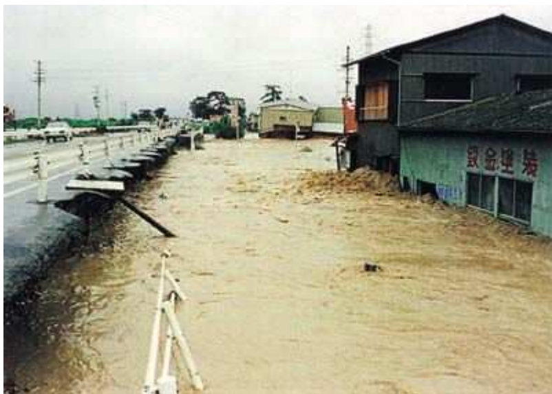
七夕豪雨による被災状況（磐田市三ヶ野付近）
