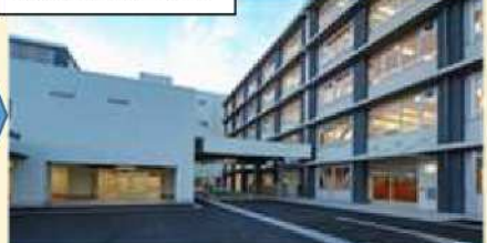
長寿命化改修+新築
