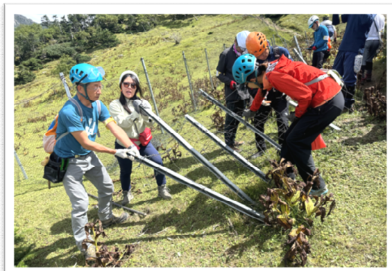
防鹿柵の補修作業
