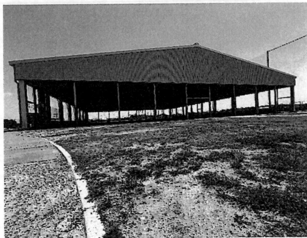
屋根付多目的グラウンド外観
