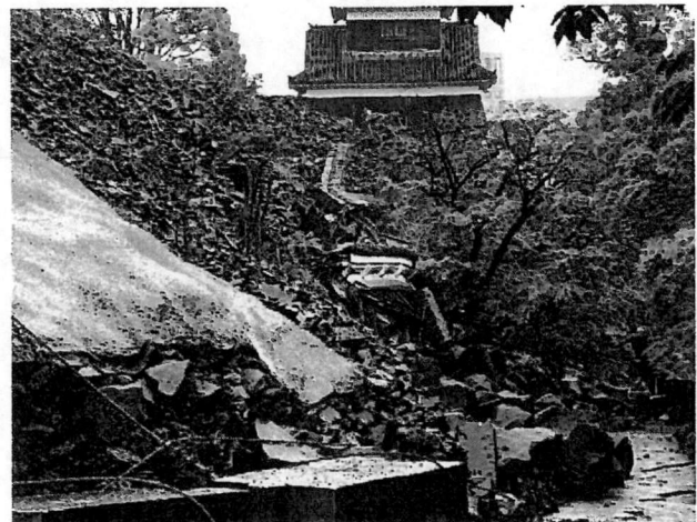
石垣の崩落状況
