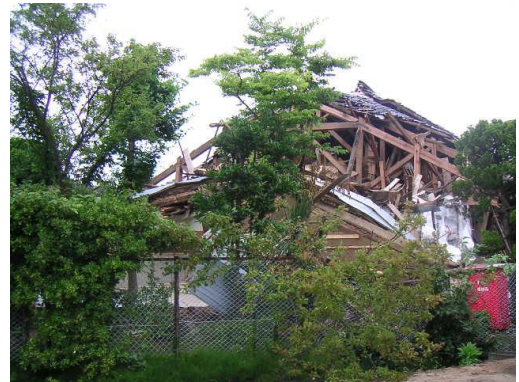
「全壊した酒造倉庫（柏崎市）」
