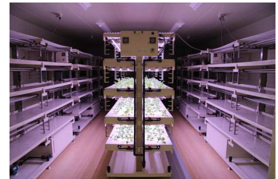
AOI-PARC (東海大学旧校舎 (沼津市) 改修)
