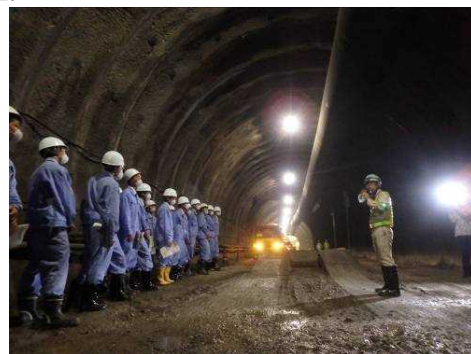
上記写真は浜当目トンネル掘削工事現場(静岡市)
