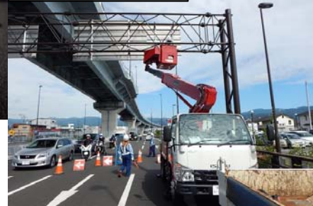
門型標識点検の状況
