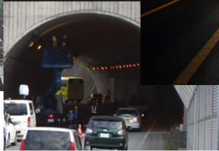
トンネル点検の状況
