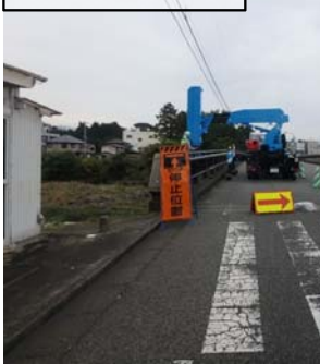
橋梁点検の状況
