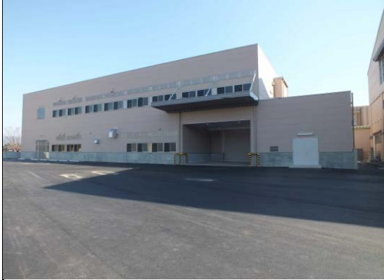
研究開発生産棟
