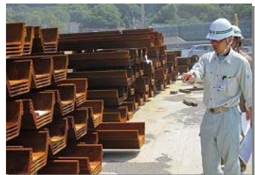
上段 釜石港と甲子川（赤字が水門仮締切工事の箇所） 下段 搬入された鋼矢板の確認を行う諸橋主査
