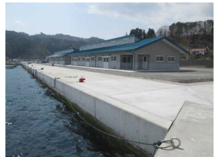
嵩上げ工事が完了した物揚場→
