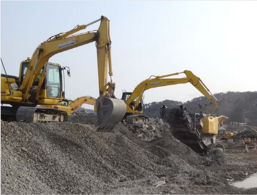
左) 大槌川防潮堤取壊し現場において、 コンクリート殻から採石を作る様子 上) 富古港でのリサイクルコンクリート 製作実験の様子 (国土交通省)
