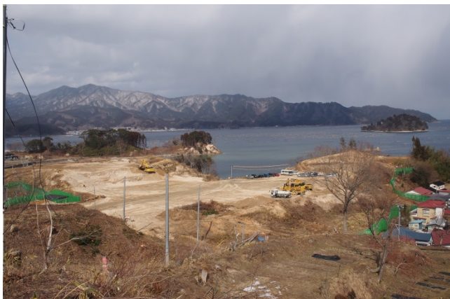
【造成（切土）が進む、③災害公営住宅建設地】
