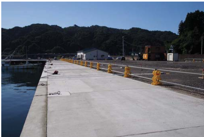
【復旧した物揚場と作業小屋建設箇所】
