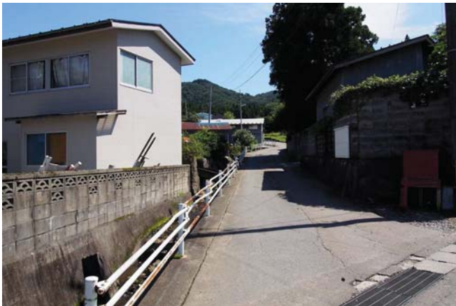
【幅員等が改良される町道（工事終了点部）】
