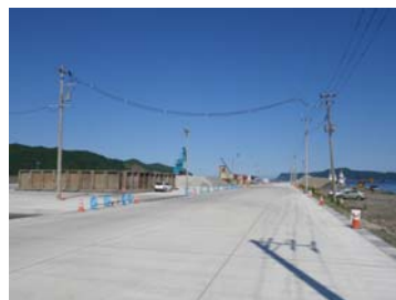
臨港道路（東西2号線） コンクリート舗装完了
