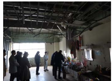
右上) 解体が始まる鵜住居地区防災センター 右下) 防災センターを視察する静岡県交通基盤部の視察団一行
