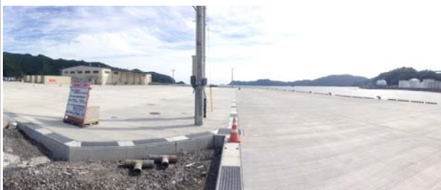
耐震-7.5m岸壁・野積み場 嵩上げ完了
