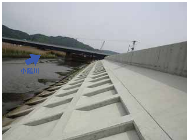
右上) 護岸工事完成 (奥の小鍬川水門の撤去工事も着実に進む)
