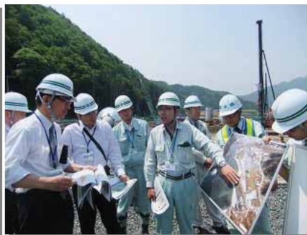
中上) 片岸海岸防潮堤の説明をする岩井主査(中央)
