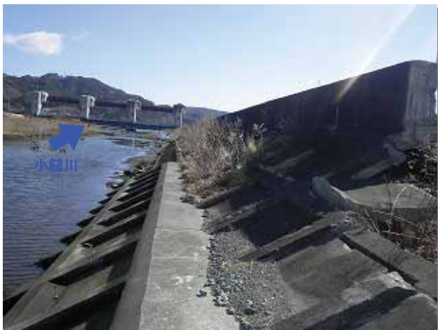
左上) 護岸工事着手前 (奥に見えるのは被災した小鍬川水門)
