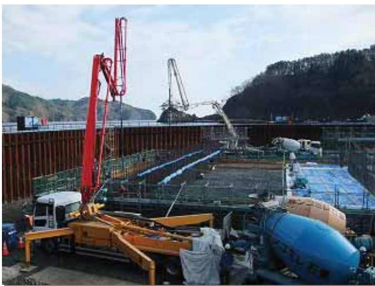
上) コンクリートポンプ車2台によるコンクリート打設
