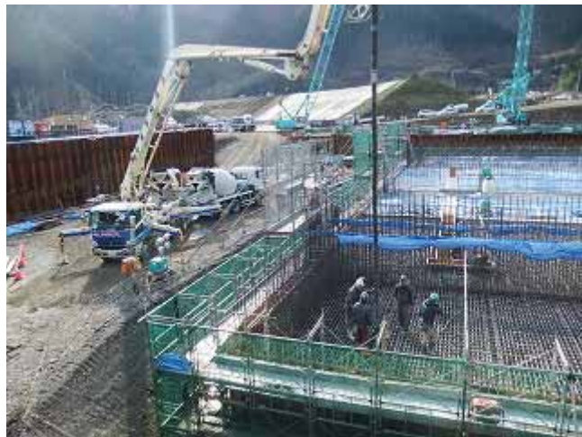
右上) ポンプ車打設
