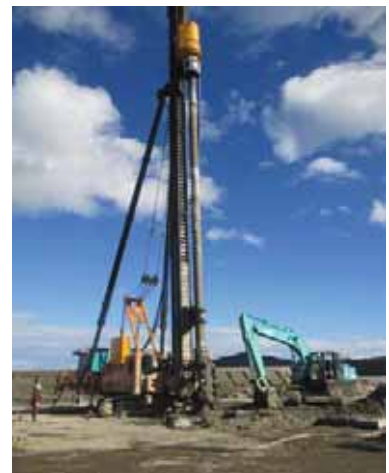
上) 深層混合処理施工状況
