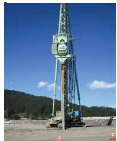
下) サンドドレーン施工状況
