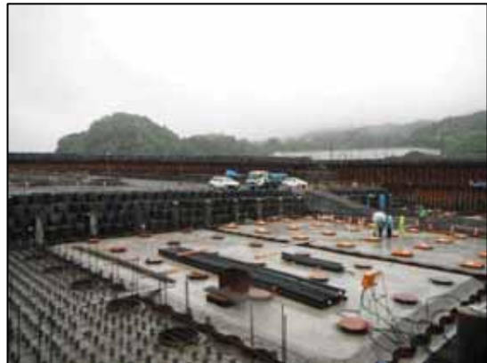
上) 甲子川 基礎杭施工完了状況
