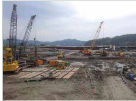
上) 大槌川 水門基礎杭施工状況
