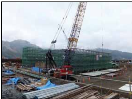
上) 鵜住居川 水門コンクリート打設状況
