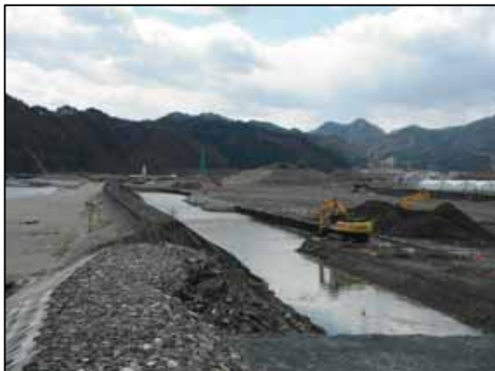
上) 片岸海岸 基礎部掘削状況
