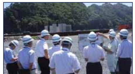
鵜住居川水門工事を説明する植田主査
