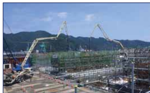
コンクリートポンプ車2台による打設状況（P1 堰柱）
