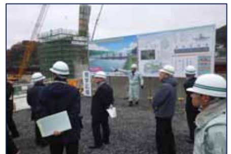
11/11 甲子川水門工事の視察状況
