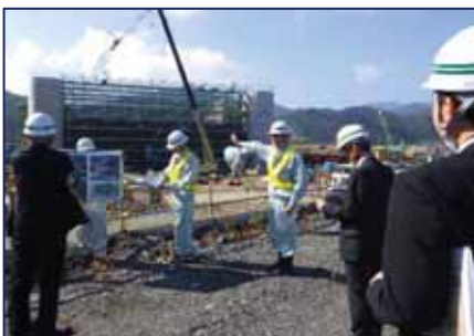
10/19 鷺住居川水門工事の視察状況
