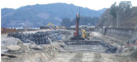
パワーブレンダー工法による軟弱地盤改良施工状況
