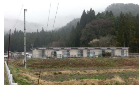
静岡県派遣職員が住む浜川目仮設住宅
