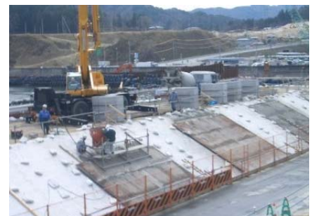
防潮堤施工現場状況 (4月8日)
