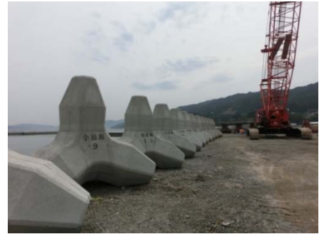
消波ブロック (15t) 製作開始! このブロックは 500 個以上製作します
