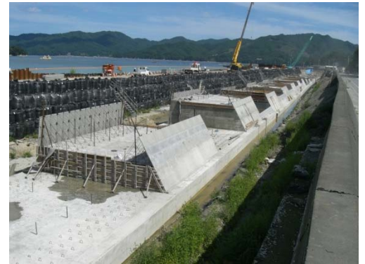
残存型枠の設置状況 (第 2 ブロック) 万全の準備で生コンの供給を待ちます
