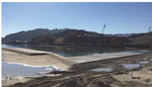
防潮堤から見た細浦工区
