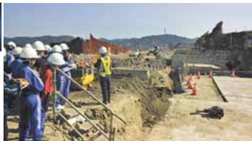
施工業者が地元の小学生を対象に 現場見学会を開催しました
