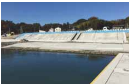
背後では織笠防潮堤が建設中です
