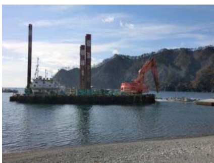
被災施設の取壊中 台船は北九州から運んできました
