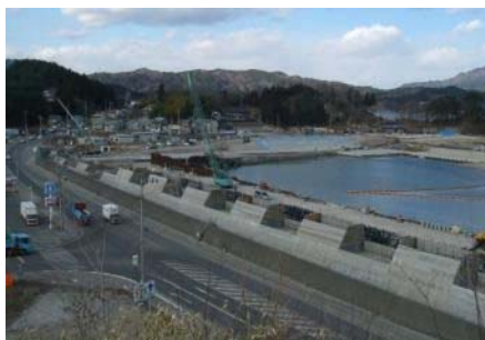
1, 2 ブロックの施工状況
