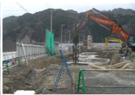
3 ブロックの施工状況 地盤改良後、盛土をしていきます
