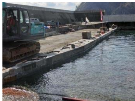
物揚場の腹付工事中 ここから約 50cm 嵩上げします
