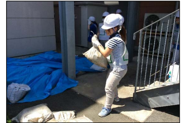
土嚢設置の様子
