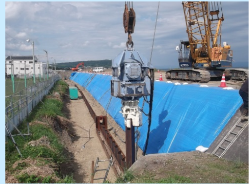
鋼矢板設置近景
