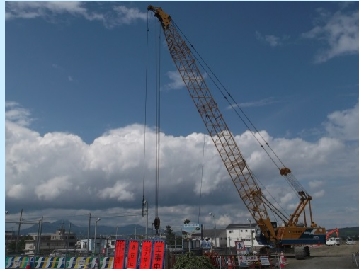
鋼矢板設置全景
