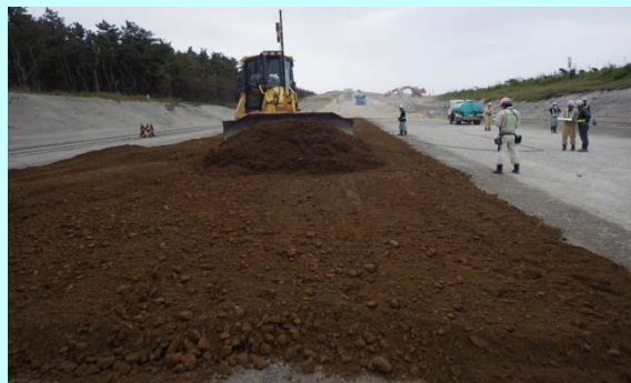
・CSG築堤状況
