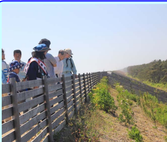
➤ 植栽が進む防潮堤を見学
