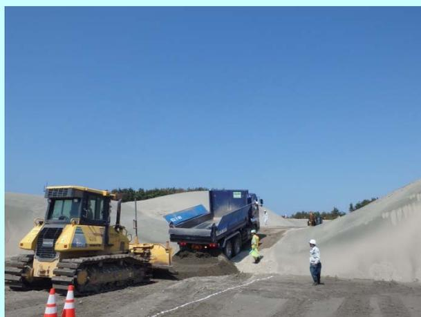
➤ 1日に 10t ダンプ約 150 台分の CSG を運搬し、築堤します。
