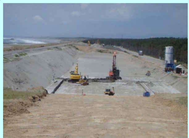
➤ 地盤改良施工中
