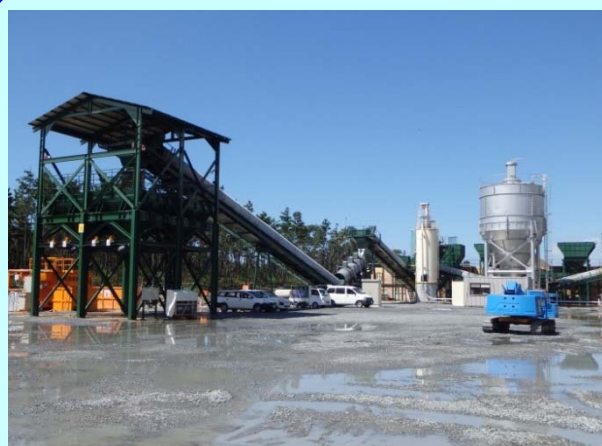
➤ 五島CSGプラントが完成
